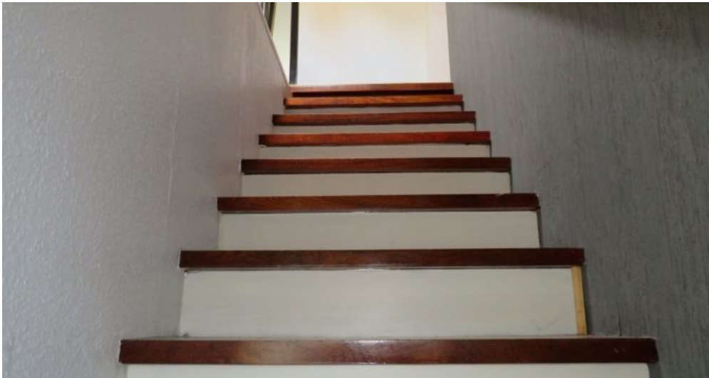
Treppe ins OG
